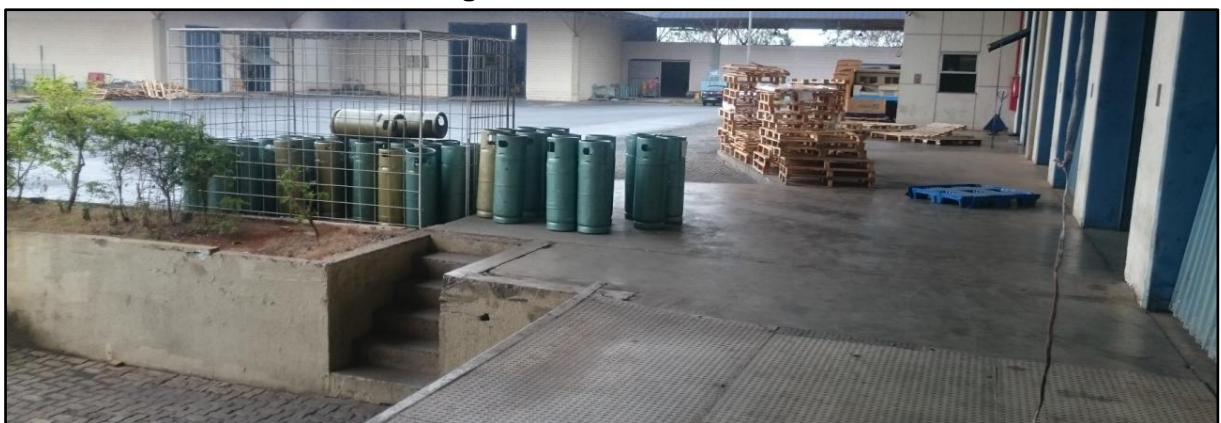
Figuras 06: Vista das docas e do local de armazenamento dos botijões de GLP.
