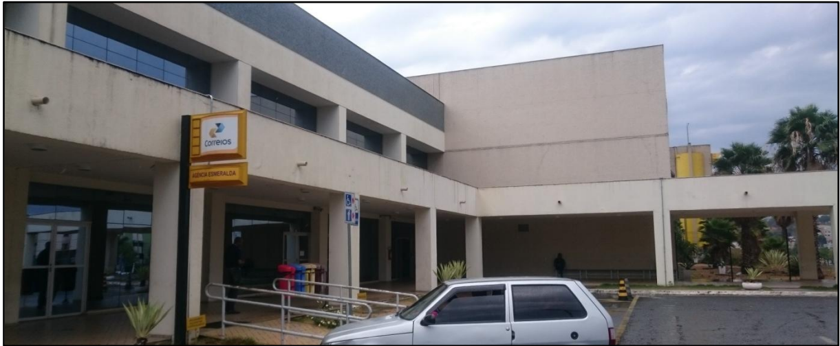
Figuras 02: Sede da reclamada.
